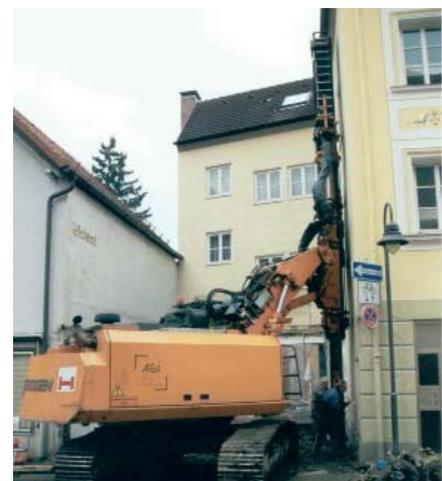
Für einen vibrationsfreien An- und Auslauf werden die Unwuchtsegmente in Position gestellt, in welcher das statische Moment 0 beträgt. Erst wenn der Vibrator seine Arbeitsfrequenz erreicht hat, werden die Unwuchtsegmente zueinander verdreht. Das maximale statische Moment ist erreicht, wenn die äußeren Segmente und das mittlere Segment der Unwuchten in gleicher Stellung sind (siehe Abbildungen Seite 4).
